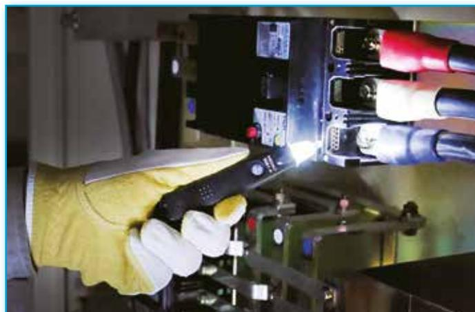
3481-20 è un rivelatore di presenza tensione senza contatto elettrico.
